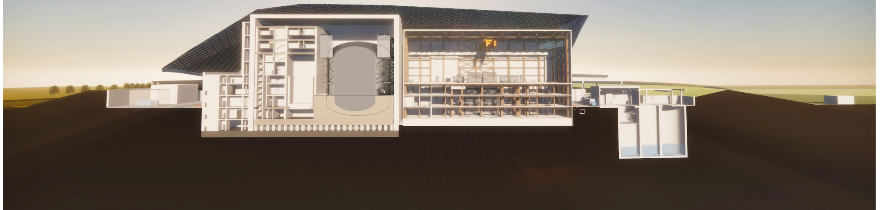
Rolls-Royce SMR: Ein dreigliedriger Druckwasser-SMR (470 MWe). Er wird stark von der britischen Regierung im Rahmen der Nuklearstrategie gefördert.
