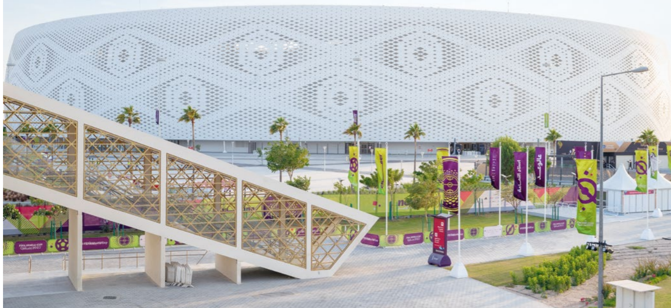
Stadion in Katar: Mehrere Schwingungstilger für die Fußgängerbrücke, die den Bahnhof mit dem Al-Thumama-Stadion verbindet, Austragungsort der Fußballweltmeisterschaft in Katar
