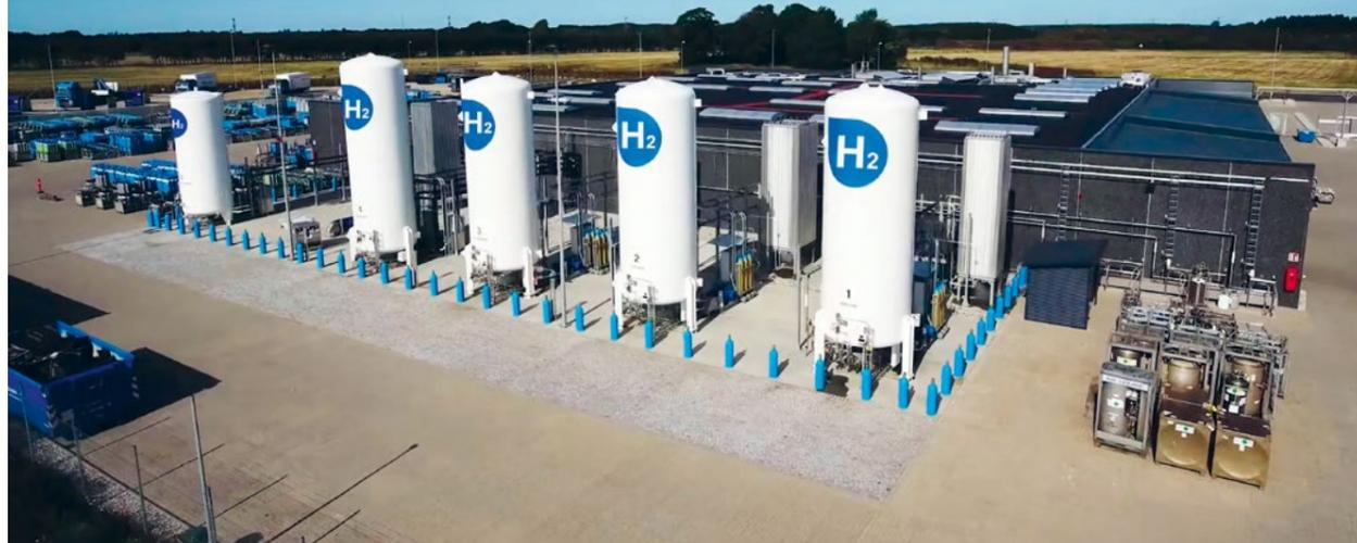
Wasserstoffanlage mit fünf Hydrogen-Speichern
